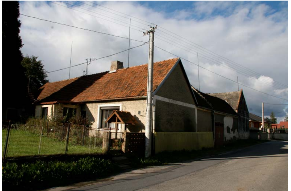
Pohled na RD č.p. 44 od příjezdové komunikace u
