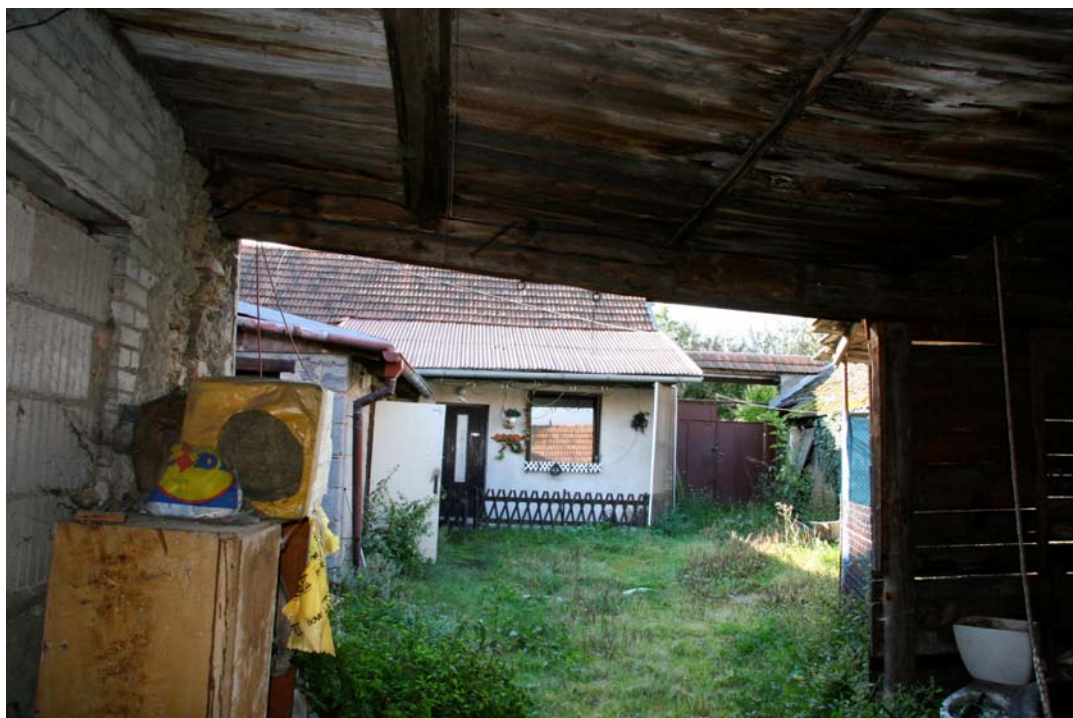
Pohled na dvůr přes objekt kolny
