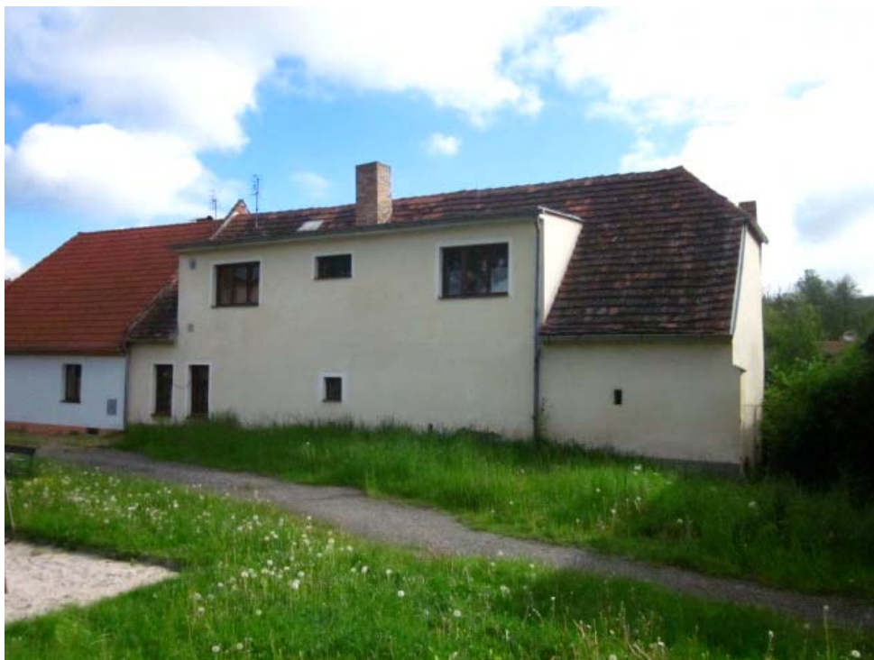
uliční pohled na RD č.p. 60
