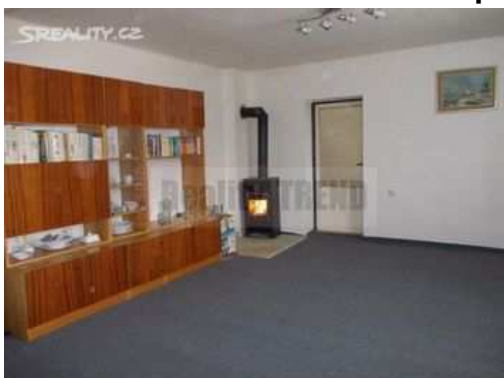
Lokální topidlo na tuhá paliva.
