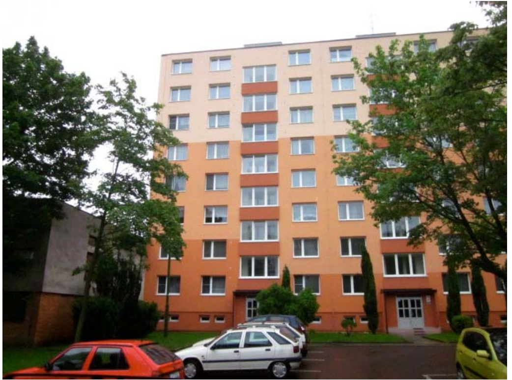
čelní pohled na bytový dům č.p. 1060,1061,1062,1063
