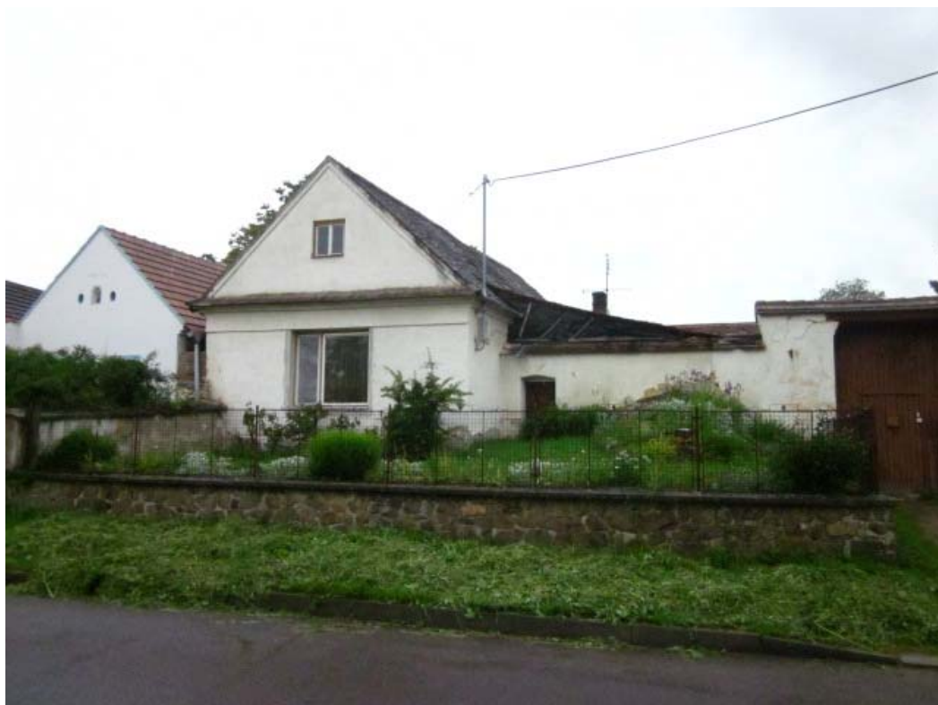
uliční pohled na RD č.p. 13
