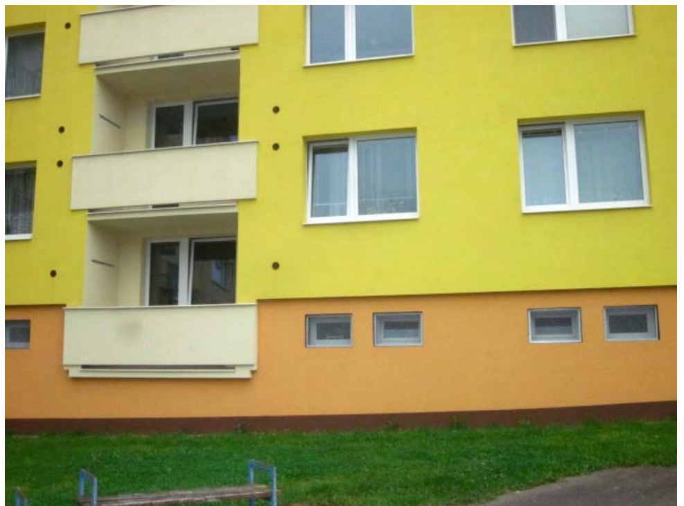
zadní pohled na bytový dům č.p. 403,404
