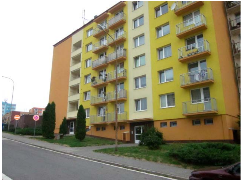
čelní pohled na bytový dům č.p. 403,404
