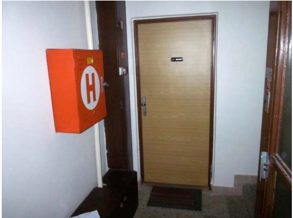
vchodové dveře bytu čp/čj 404/2
