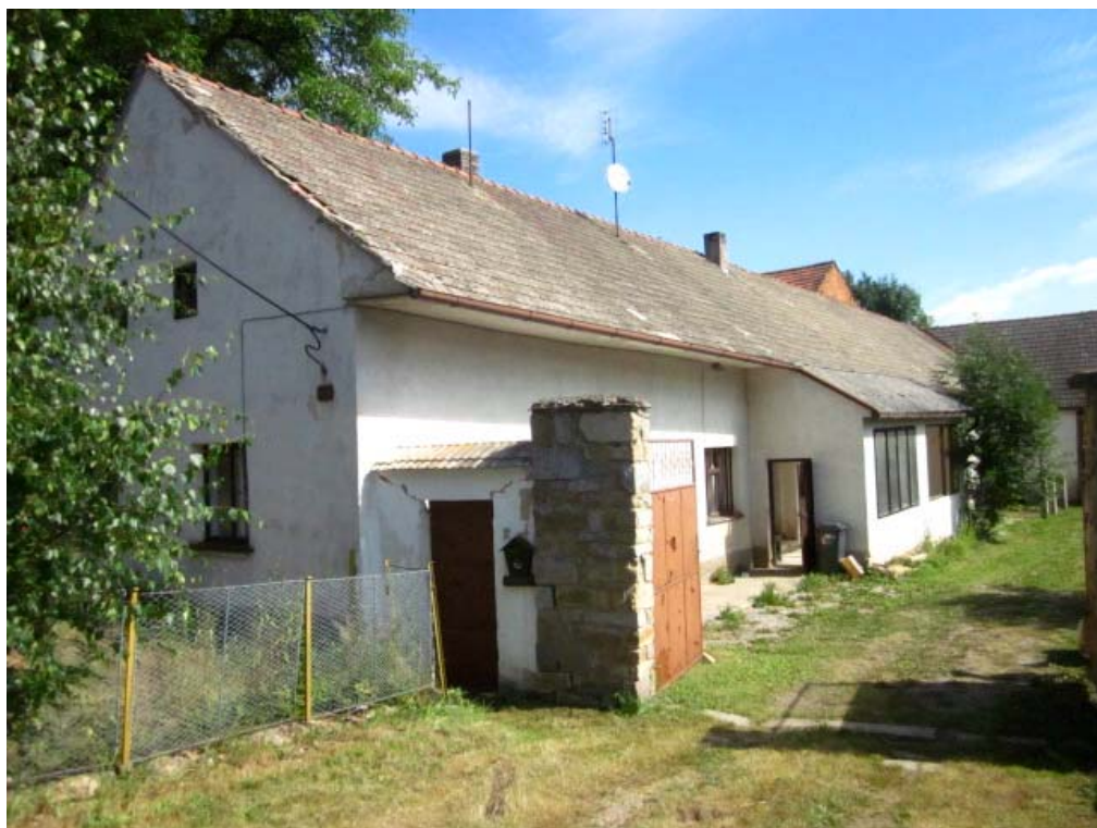
uliční pohled na RD č.p. 5
