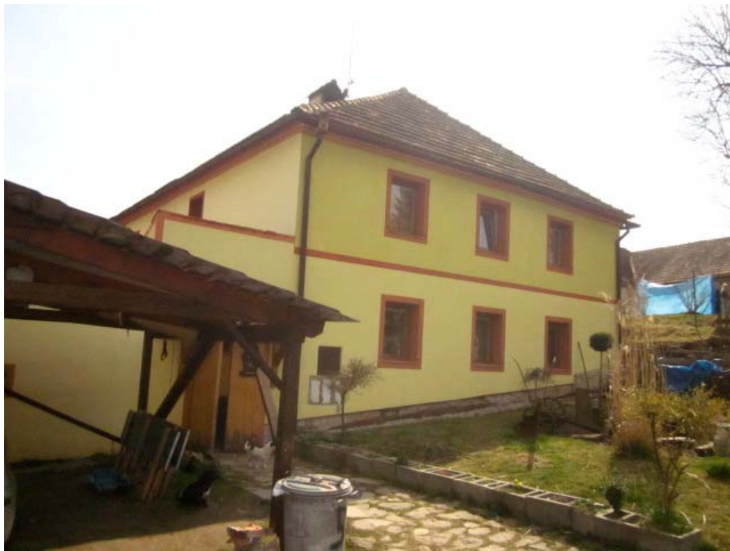
pohled na RD č.p. 4 od příjezdové komunikace
