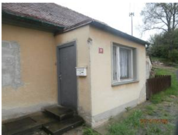
Vstup do domu č.p. 91 přes pozemek St. 392
