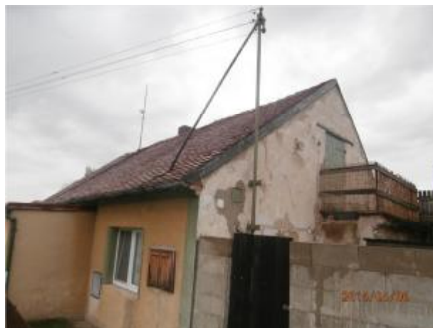
Pohled na dům č.p. 91
