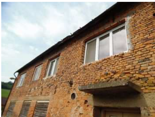
pohled na vyměněná okna
