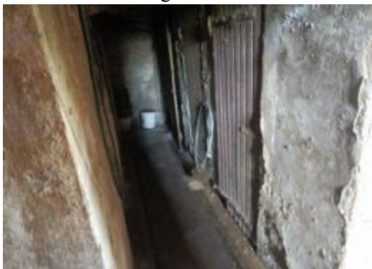
sklepní koje v suterénu domu
