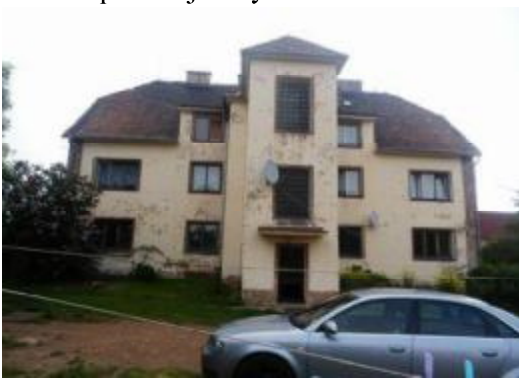
pohled západní - dvorní část
