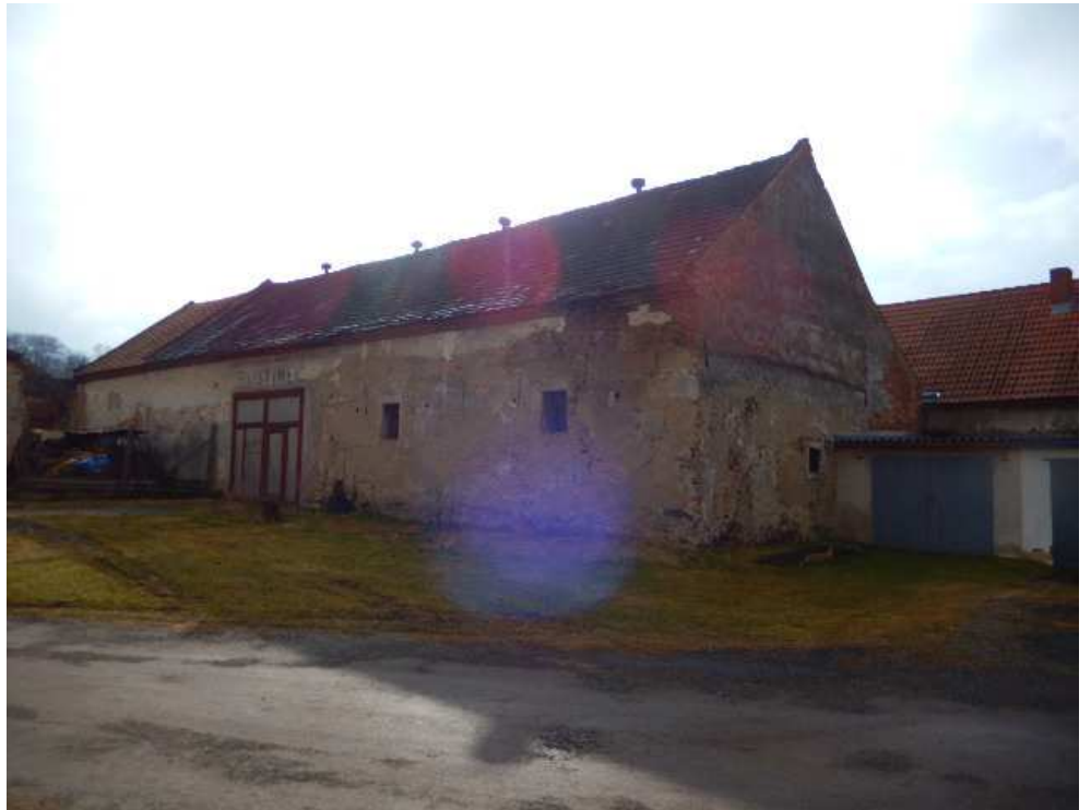
pohled na zemědělskou stavbu bez č.p./č.e.
