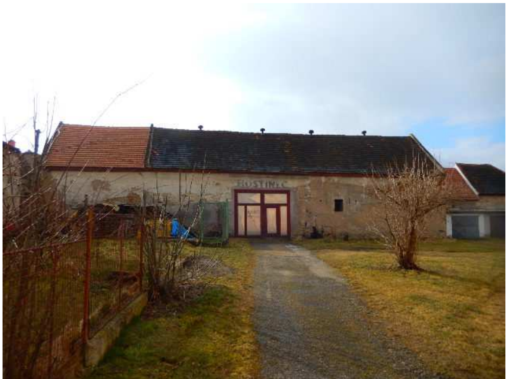
pohled na zemědělskou stavbu bez č.p./č.e.
