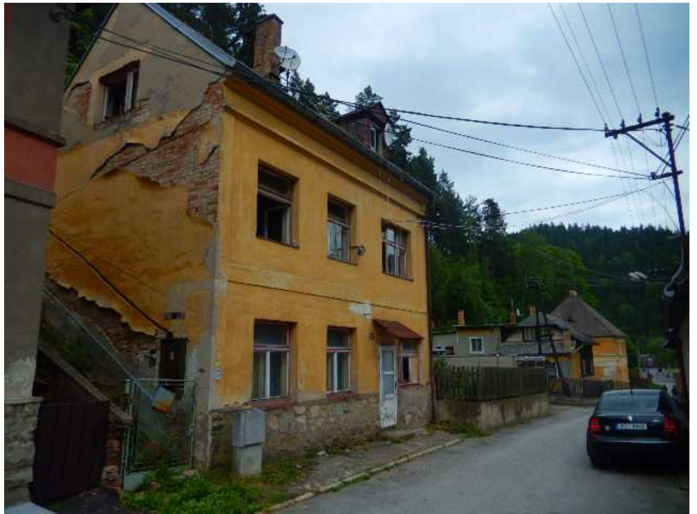
pohled na RD č.p. 141 z příjezdové komunikace
