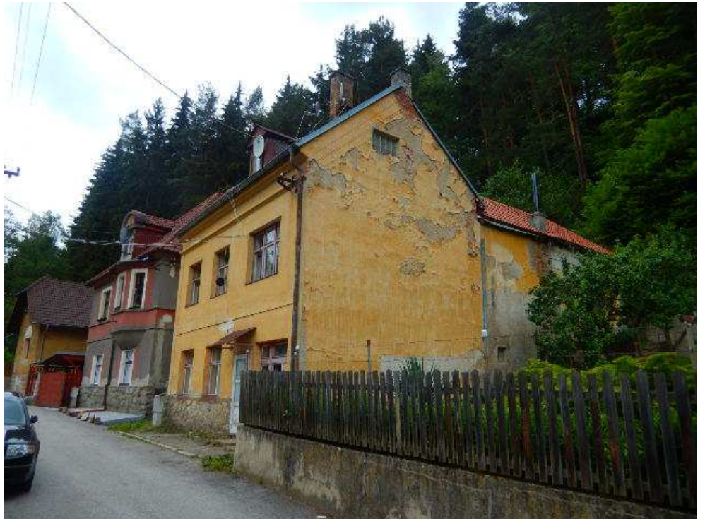
pohled na RD č.p. 141 z příjezdové komunikace
