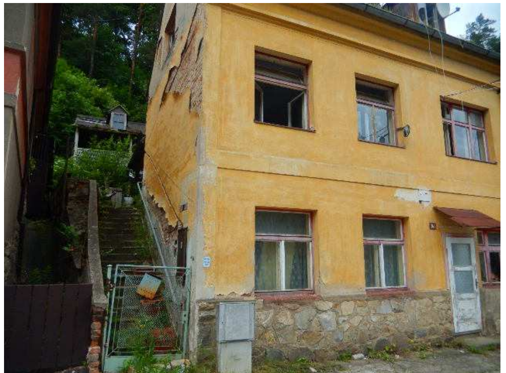
pohled na RD č.p. 141 z příjezdové komunikace
