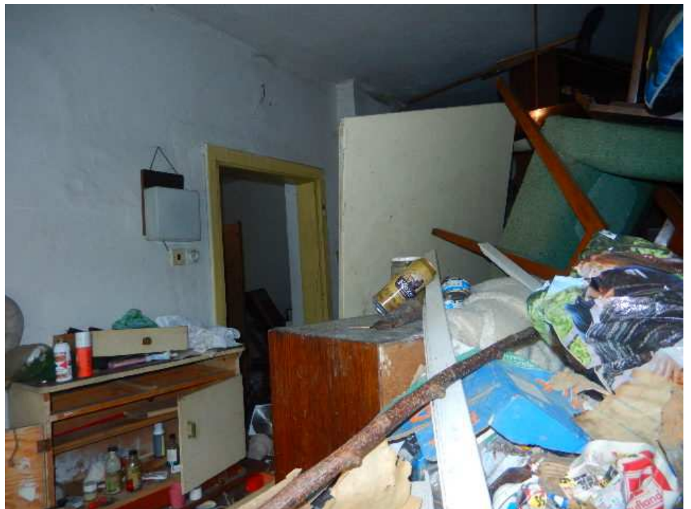
průhled do pokoje v 1.NP objektu z chodníku
