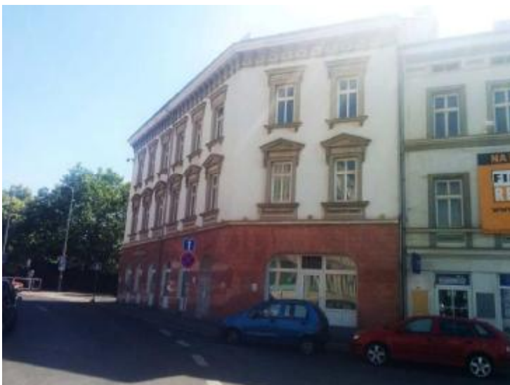
S pohled na objekt.jpg 26.08.2015
