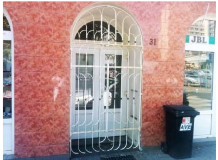
Vchod bytové části.jpg 26.08.2015
