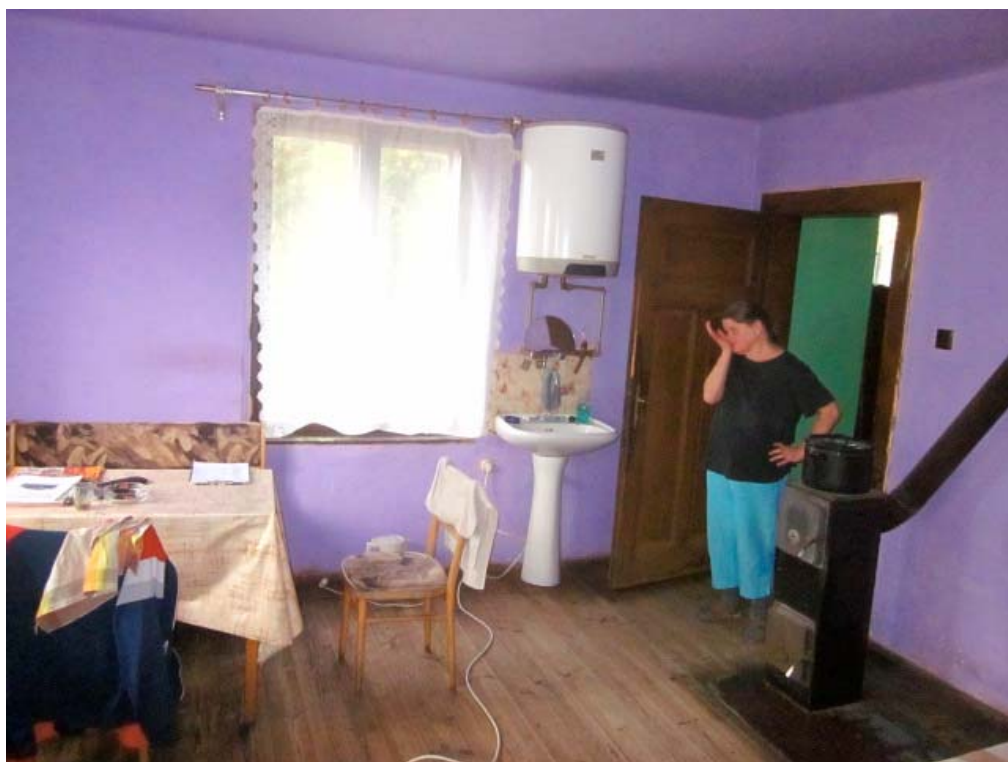
pokoj s umyvadlem a bojlerem v objektu RD č.p. 3
